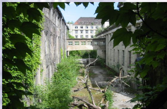
Ansicht Innenhof unsaniert
